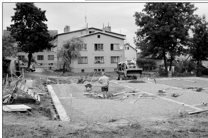
Výstavba čtyř pečovatelských bytů v lokalitě „U BYTOVEK“
